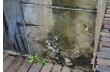
Fig. 6: schilferend glazuur en oude restauraties op het zuid-element, westelijke benedenhoek.
